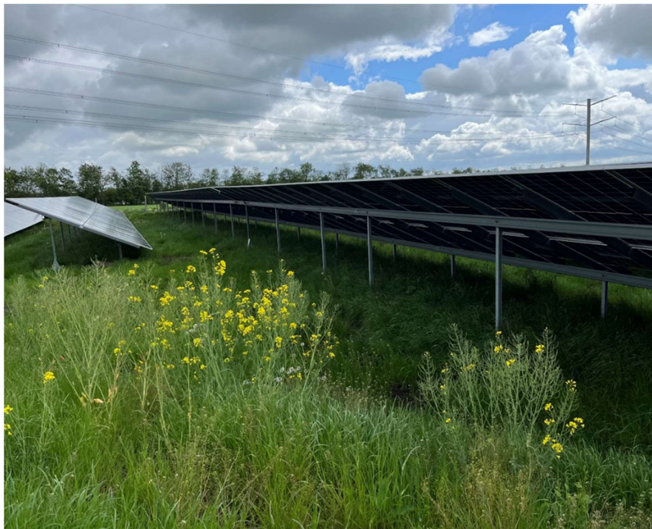
Figur 4 - Eksempel på solpaneler fastgjort på sydvendt stativ.
