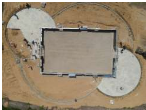
Dronefoto af pladsen i byggefasen
